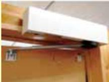
既存の**開き戸**や**引き戸**に取り付けて自動ドアにすることができる画期的な**後付け型自動ドア駆動ユニット**です。ドアの上部の枠に駆動部の本体を取り付け、伸縮するアームの先端を扉に固定し、そのアームを本体の駆動部で動かすことにより扉を開閉するようにしています。
